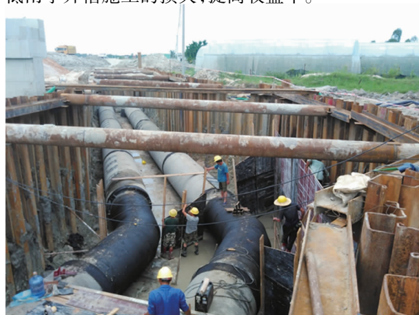
图4 原水管道及支墩施工
