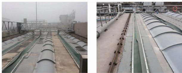
图 1 某曝气沉砂池密封加罩
