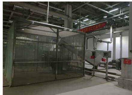
图10 砂水分离器封闭罩
