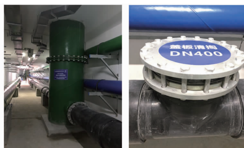
图6 污水检查井筒与正三通法兰盖板检修口实体图片
