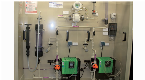
图7 药剂投加设备安全柜
