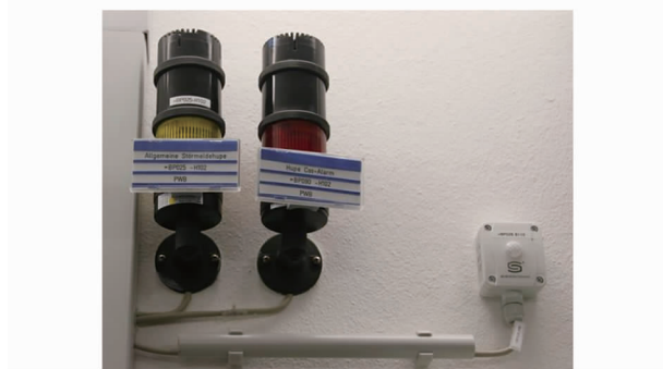
图 2 取水点报警装置
