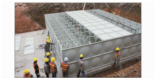
图 5 顶板吊装
