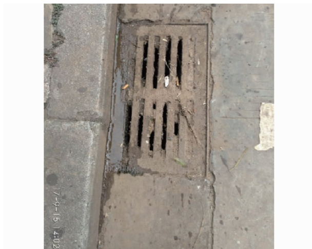
图2 许家湾路雨水口(堵塞)
