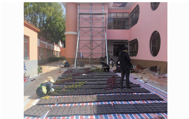
图 4 垂直绿化墙施工
