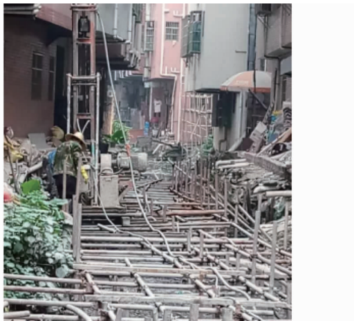
图3 优化高压旋喷桩作业
