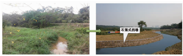
图7 河道边坡改造为石笼式挡墙实景
