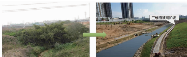
图8 河道边坡改造为三维植被网护坡实景
