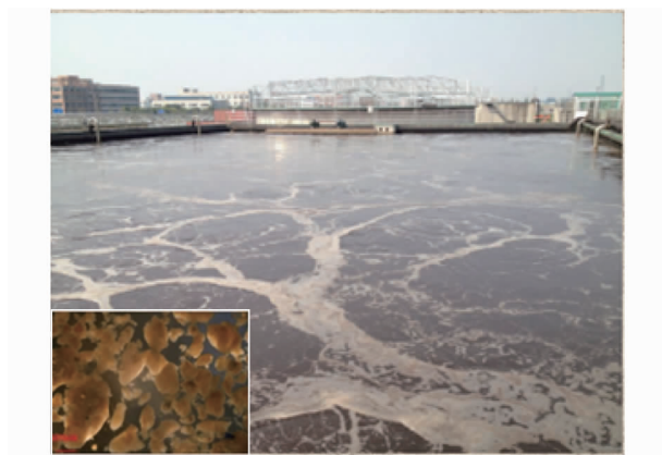
图6 盐仓污水处理厂好氧颗粒污泥
