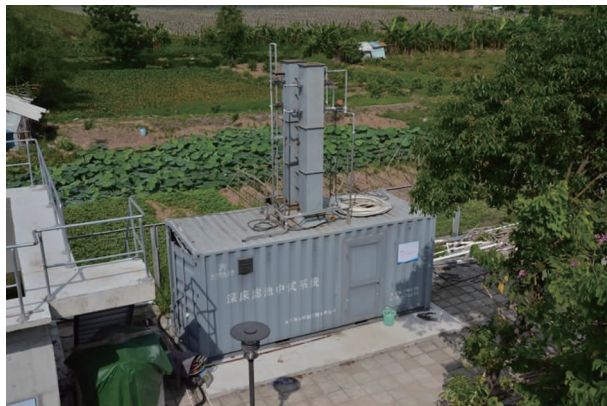
图1 深床滤池装置
