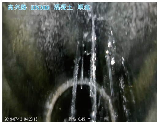
图1 管道渗漏
