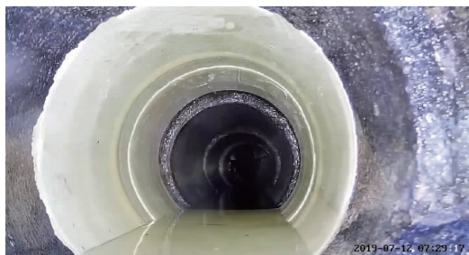
图 5 管道修复后效果
