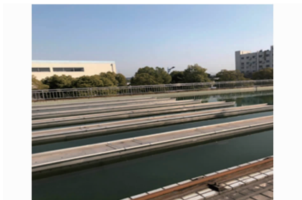
图2 加盖的指型集水槽
