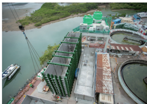
图9 以 DfMA 搭建移动床生物膜反应池
