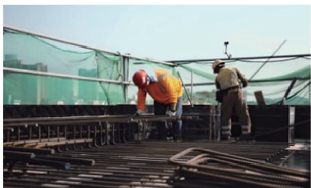
图7 以场外钢筋预制组件兴建临时污水处理厂的土木结构
