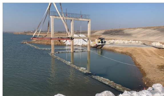
图5 取水头部施工
