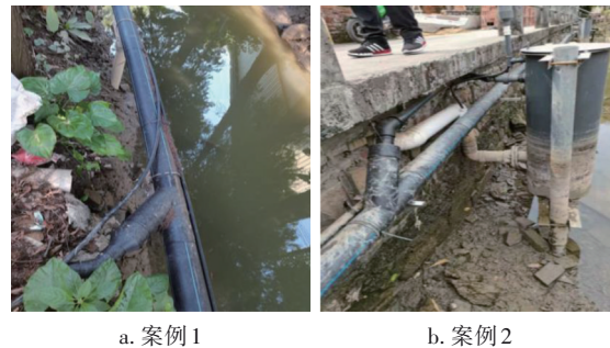
图13 负压管道的正确连接方式
