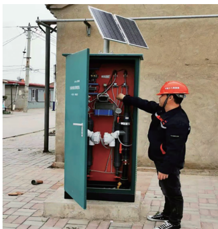
图 7 自动补气装置
