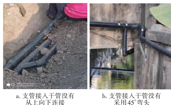
图12 负压管道的错误连接方式
