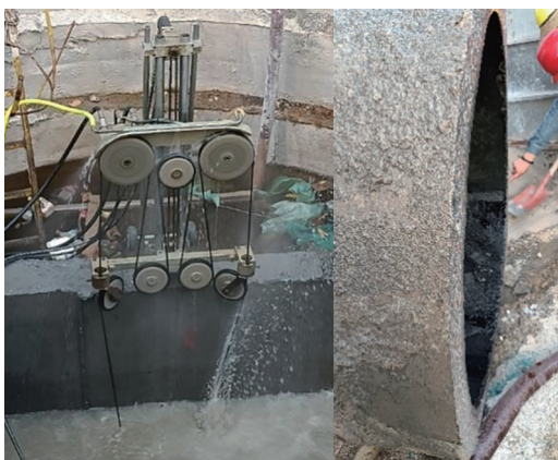
图 7 管道绳锯切割及切口断面
