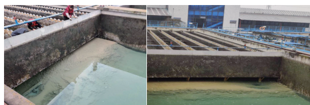
图3 斜管沉淀区的下部积泥
