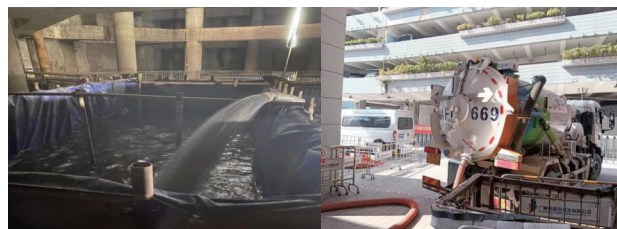
a. -14层沉淀池 b. 高扬程吸污车吸污作业
