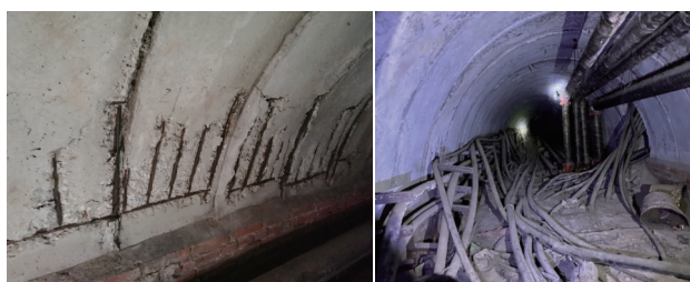
a. 结构裂缝、钢筋裸露、锈蚀 b. 管线杂乱、淤泥堆积
