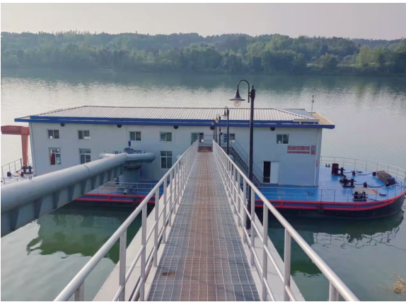
图 2 浮船实景 Fig.2 Actual view of the floating boat
