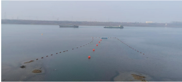
图6 应急取水系统实景
