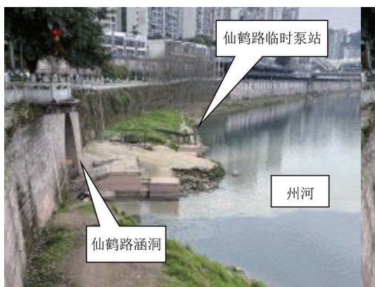
图1 仙鹤路涵洞及临时泵站现状
