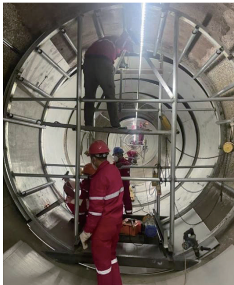
b. 现场施工
