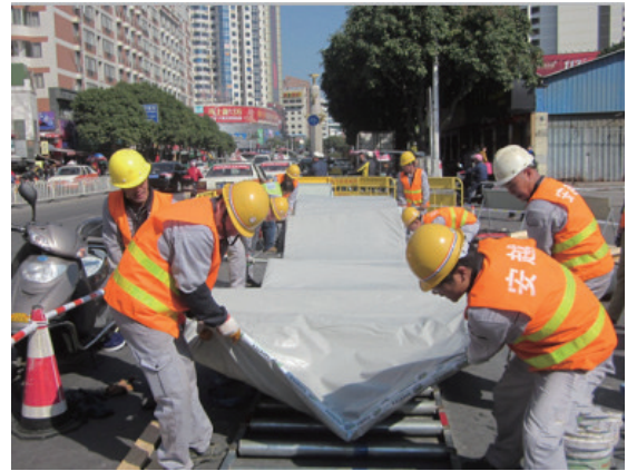
图3 排骨架辅助牵拉软管
