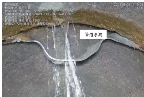
图 2 沿河管道 CCTV 排查
