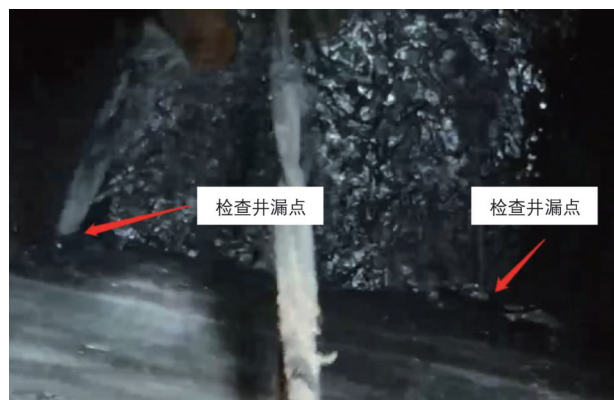
图 3 沿河检查井 CCTV 排查
